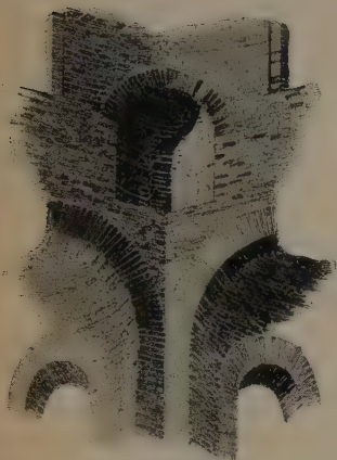
Fig. 86. — Détail de construction de Saint-Vital de Ravenne (d'après Rivoira, Le origini della architettura lombarda ).
